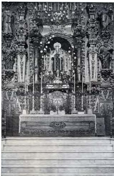
Escalinata de acceso al presbiterio del Carmen antes de su reforma
